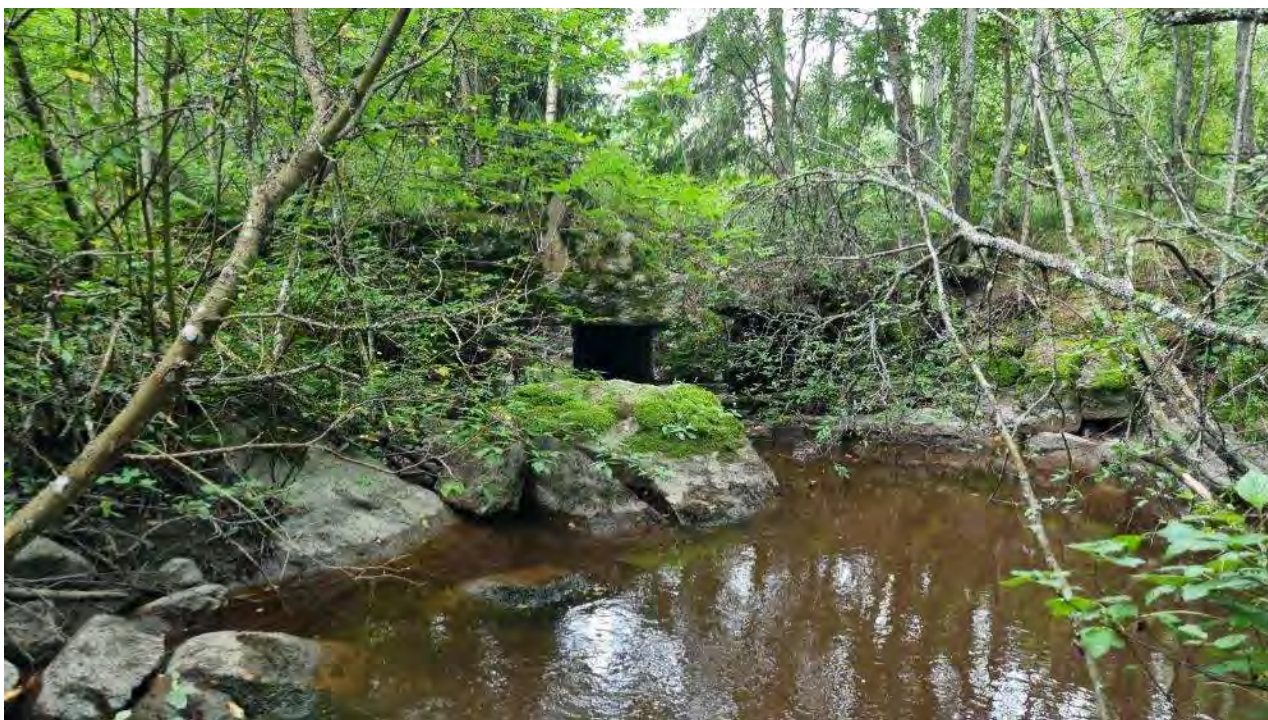
Kuva 7. Myllyn pohjoispuolella on suurista lohkokivistä tehty silta. Kuvattu etelään. SK.
