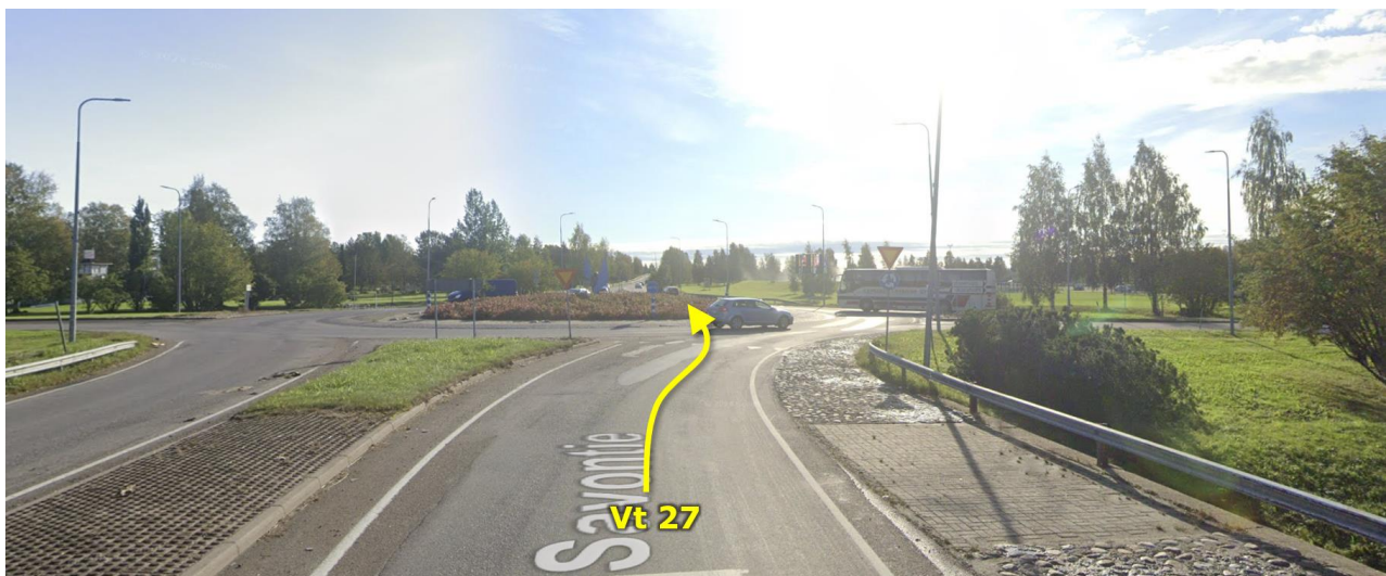
Kuva 15: Valtatien 27 kiertoliittymä Ylivieskassa (POS B3) (Google Maps 2025).
