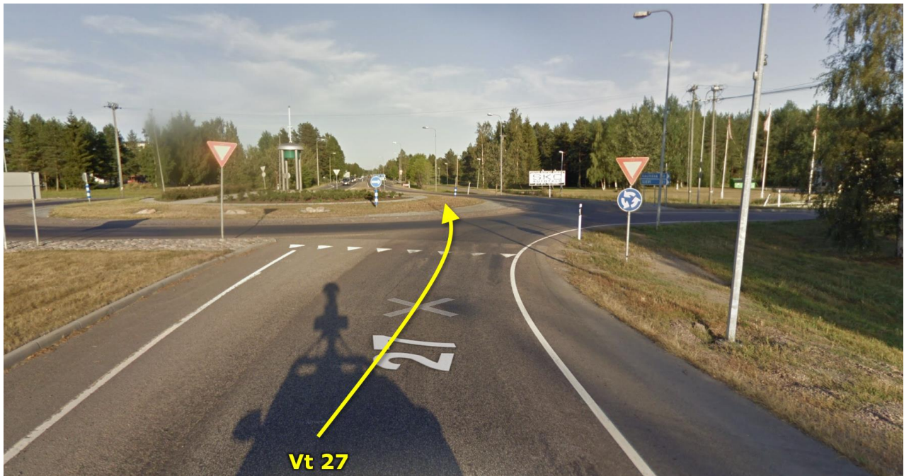
Kuva 14: Valtatien 27 kiertoliittymä Ylivieskassa (POS B2) (Google Maps 2025).
