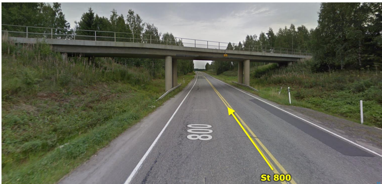
Kuva 17: Seututien 800 ylittävä matala rautatiesilta (Google Maps 2025).
