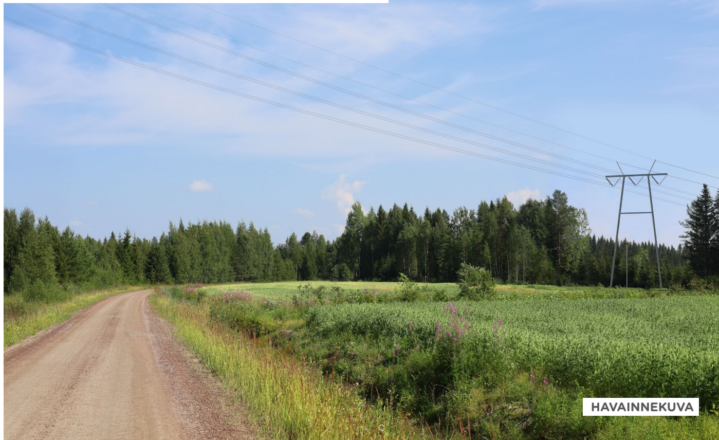
KUVAUSPAIKKA SVE1 SÄHKÖNSIIRTO OJANPERÄNTIE 960
