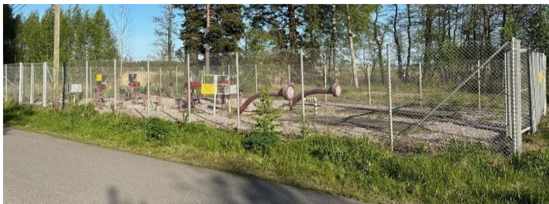
Bild 3-3. Ventilstation.
