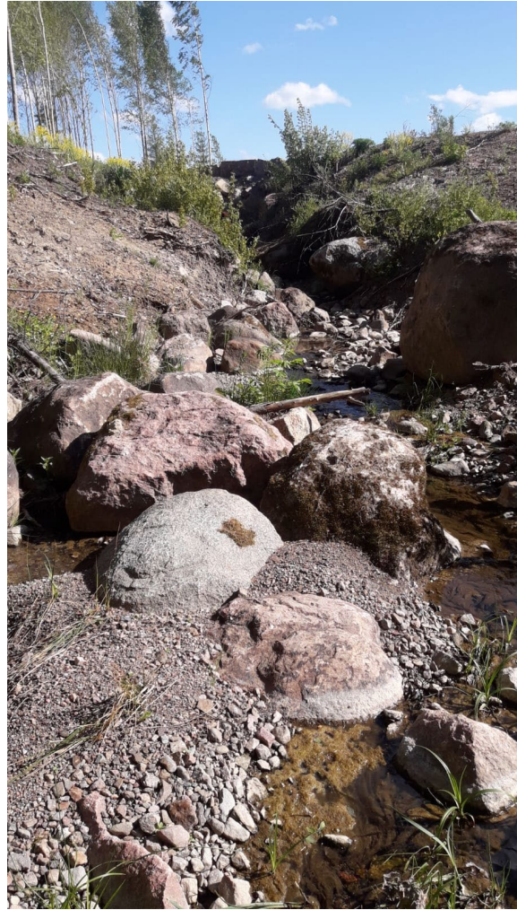
Uoma välittömästi vasta rakennetun sillan alapuolella.
