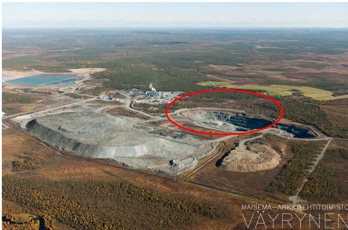
Kuva 114. Täytettävä Suurikuusikon avolouhos kuvassa punaisella ympyröitynä. Kuvaan on mallinnettu sivukiven läjitysalue tasolla 250 mpy. Ilmakuva on otettu 8.9.2010. Kuva on otettu lounaasta lentokoneesta katsottuna kohti kaivosta.
