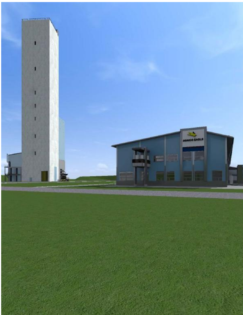
Kuva 24. Suunnitellun nostokuilun ja nostotornin (kuvassa vasemmalla) sijainti uuden kaivoskonttorin läheisyydessä. Nostotornin korkeus on noin 93 metriä.
