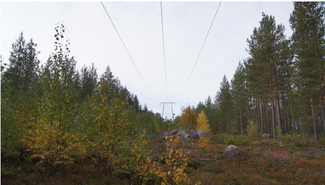
Kuva 8.26. 110 kV voimajohto metsämaastossa. Suunniteltu voimajohto on samanlainen.
