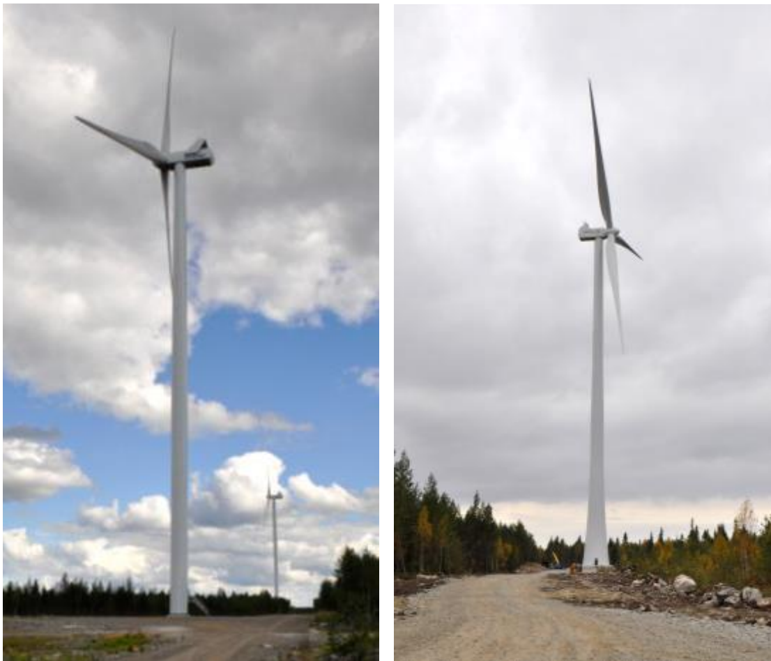
Kuva 4.2. Vasemmalla teräslieriötorni ja oikealla rakenteilla oleva hybriditorni.
