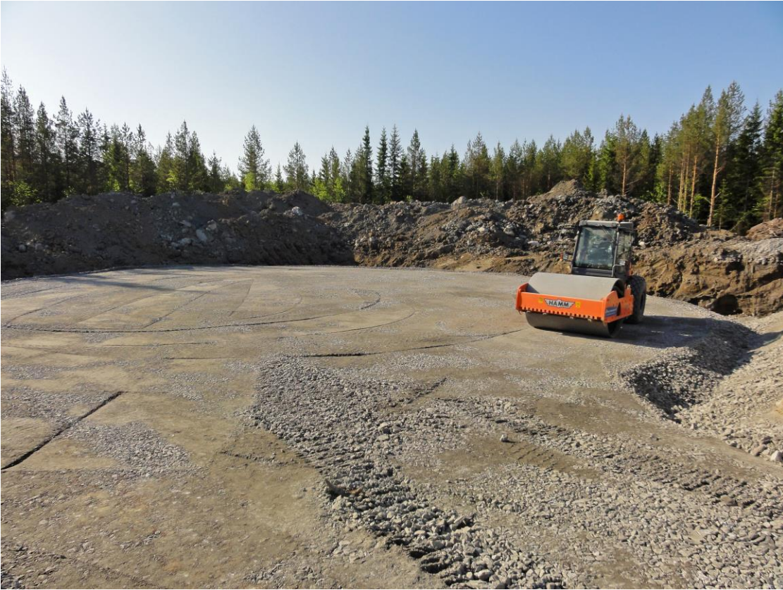
Kuva 4.6. Perustustusten pohjan tiivistys. (Kuva: Ville Suorsa / FCG).
