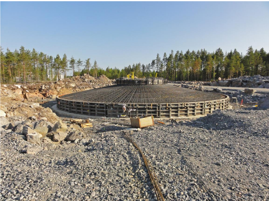
Kuva 4.7. Tuulivoimalan teräsbetoniperustusten rakentamista. (Kuva: Ville Suorsa, FCG)
