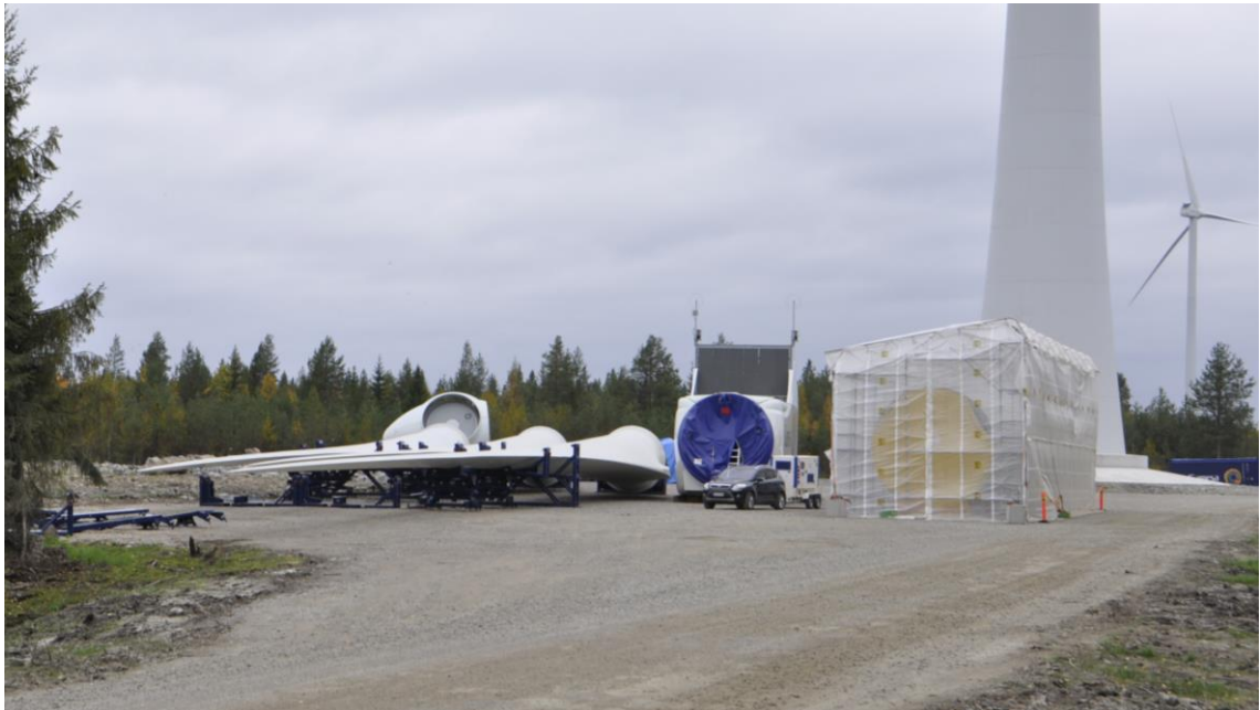
Kuva 4.3. Tuulivoimalan konehuone, naselli ja siivet odottavat asennusta. (Kuva: Leila Väyrynen/FCG).
