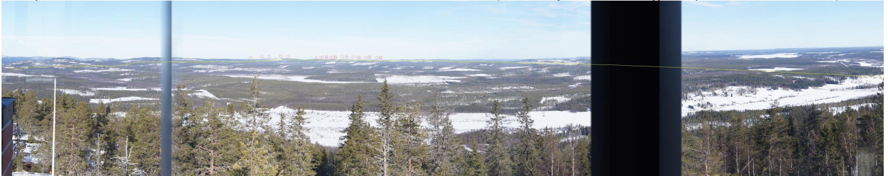
Kuvauspiste 15. VE2. Valokuvasoite Aavasaksan näkötorjista. Voimaloiden kokonaiskorkeus on 230 metriä, kameran objektiivi 18 mm. Kaaviokuva voimaloiden näkyvyydestä. Etäisyys lähimpään Palovaaran voimalaan 18,4 km ja Ahkiovaaran voimalaan 17,3 km.
