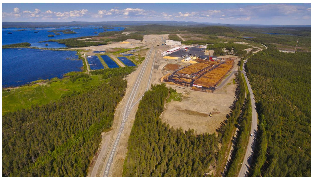
Kuva 2-3. Ilmakuva laitosalueen ympäristöstä nykytilanteessa.
