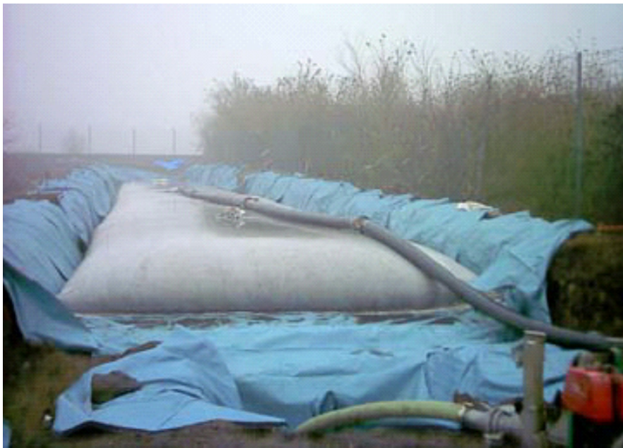
■ Kuva 4-4. Sedimentin geosäkkikuivaus.
