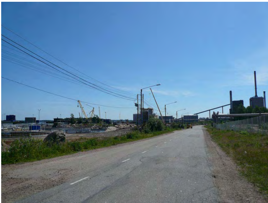
Kuva 12-7 Mussalo: Näkymä Jämskäntieltä luoteesta kohti hankealuetta (hankealue kuvassa tien vasemmalla puolella).
