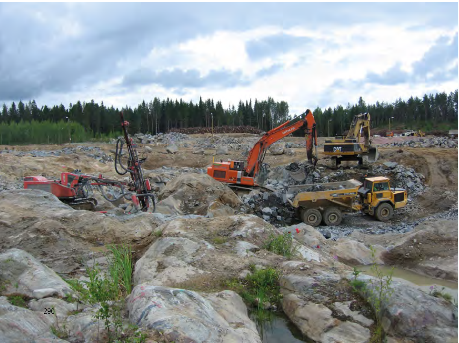
Kuva 9–8. Avolouhinnassa käytettäviä työkonetta.
