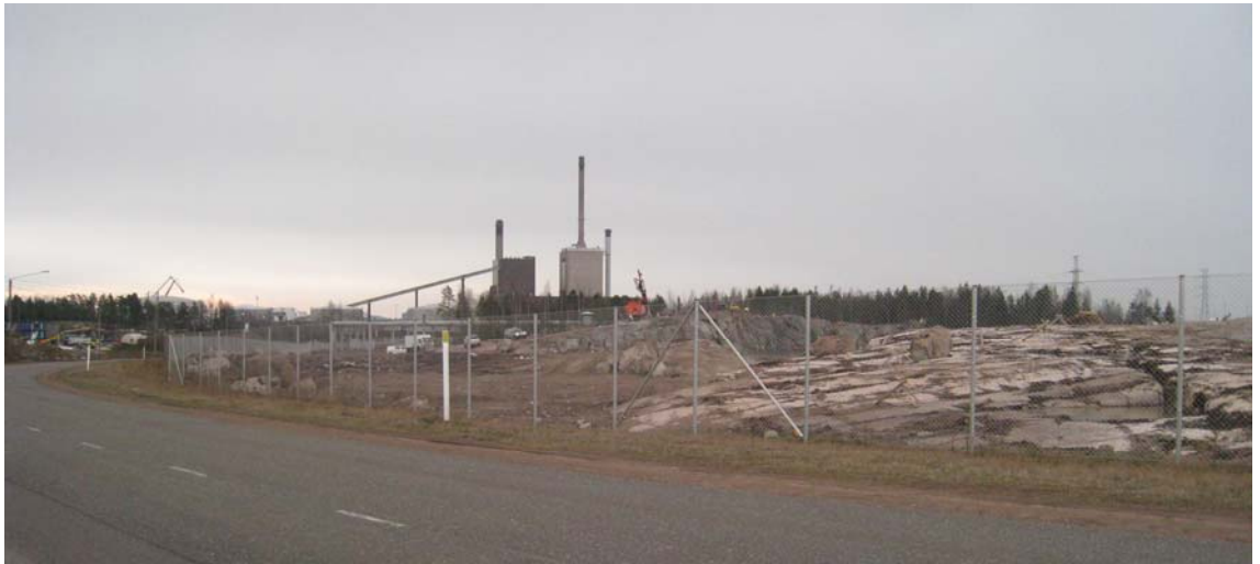
Kuva 9. Suunnitellun palvelupisteen alue Jämskäntieltä nähtynä huhtikuun loppupuolella 2008. Alueella oli louhinta ja tasaustyöt menossa. Kuvassa näkyvä kallio on tarkoitus louhia Jämskäntiehen asti. Taustalla näkyy PVO:n voimalaitos. Kuva ECOBIO Oy.
