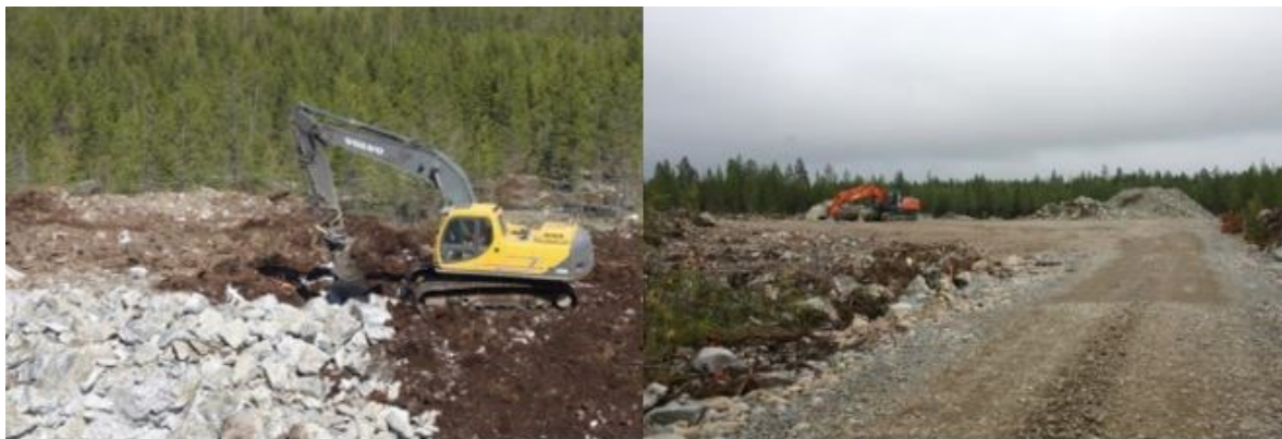
Bild 5.8 Byggandet av vindkraftsparken inleds med att bygga vägar och service-/resningsområden (FCG).
