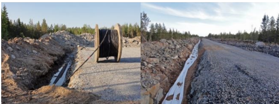
Bild 5.9 Jordkablarna grävs ner i anslutning till servicevägarna (FCG).
