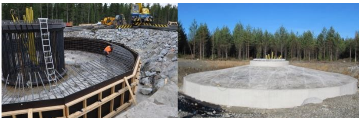
Bild 5.10 Byggande av vindkraftverkens fundament (FCG).
