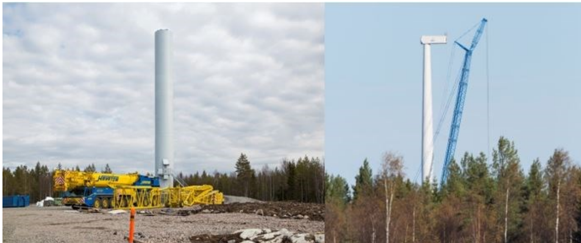
Bild 5.11 Montering av vindkraftverk (FCG).
