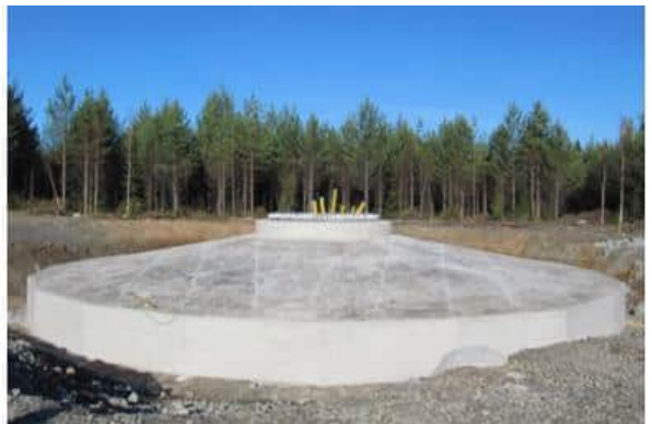
Kuva 5.12 Tuulivoimalan perustusten rakentamista (FCG Finnish Consulting Group Oy).
