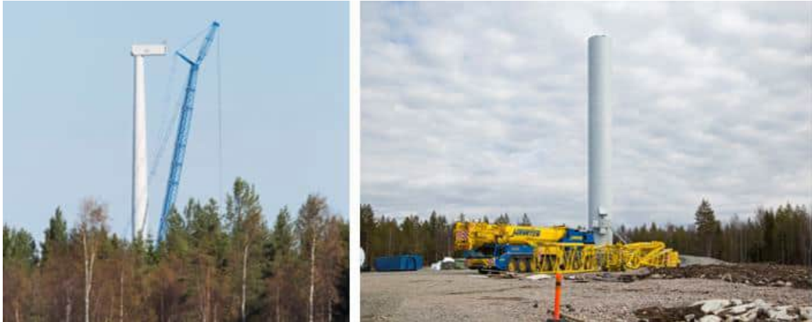
Kuva 5.13 Tuulivoimalan kokoamista (FCG Finnish Consulting Group Oy).
