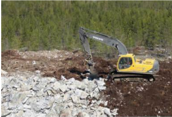
Kuva 5.10 Tuulivoimapuiston rakentaminen alkaa huoltoteiden ja pystytysalueiden rakentamisella (FCG Finnish Consulting Group Oy).
