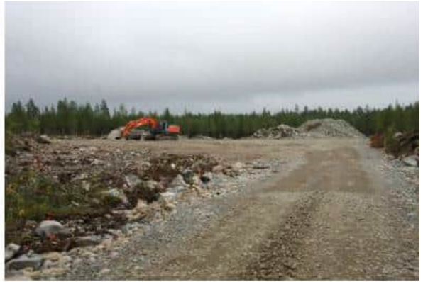
Kuva 5.10 Tuulivoimapuiston rakentaminen alkaa huoltoteiden ja pystytysalueiden rakentamisella (FCG Finnish Consulting Group Oy).
