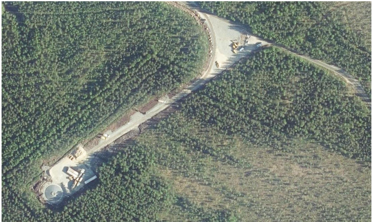
Kuva 8. Esimerkki tuulivoimalan rakennustyömaasta. Ilmakuvan lähde: Maanmittauslaitos 2022.
