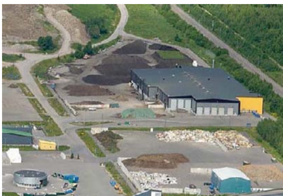
Kuva 5-8 Kompostointilaitos (kuva: www.phj.fi )
