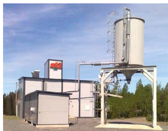
Kuva 5-11 Bioetanolin valmistuslaitos (kuva: www.st1.fi )
