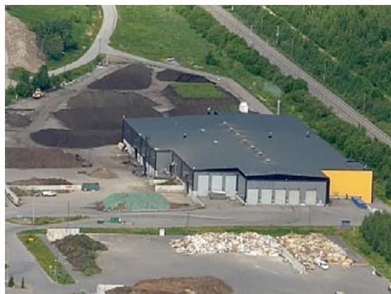
Kuva 4-3 Kompostointilaitos (kuva: www.phj.fi )
