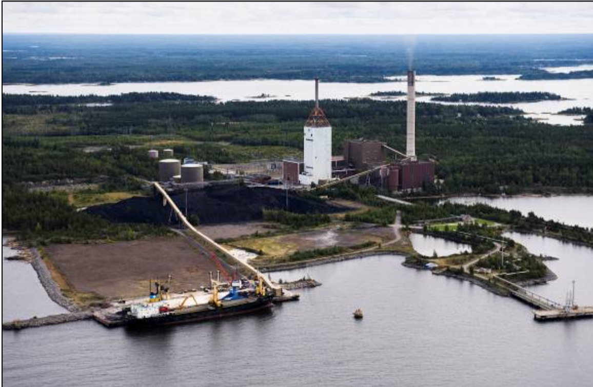
Kuva 26. Voimalaitosalue lännestä päin. Edessä satama, keskellä kuvaa öljykattila ja öljykattilan oikealla puolella kivihiilikattilalaitos
