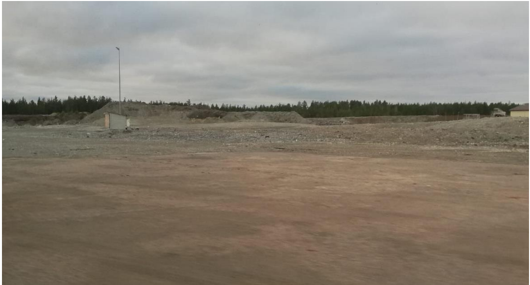
Kuva 27. Vanhan terästehtaan kenttäalueita, jotka on tarkoitus ottaa sataman käyttöön tulevaisuudessa. Maaperä on kuonaperäistä karkeaa maalajia. Kuva otettu marraskuussa 2018.
