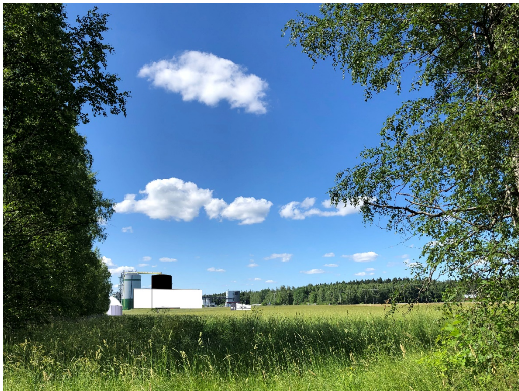
Kuva 8.12 Kuvapisteen 2 maisema laajennuslanteessa VE1.
