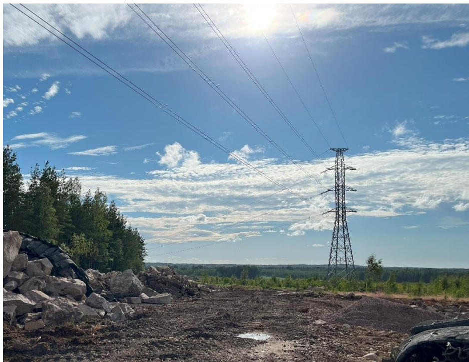
Kuva 2-4. Vahvistettavan voimajohdon pylvästyppi.
