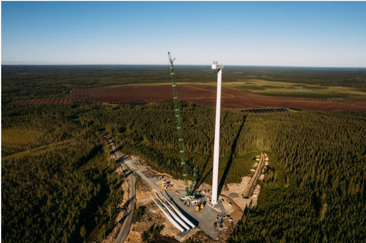
Kuva 3-3. Tuulivoimalan kokoaminen. © Ilmatar Energy Oy.
