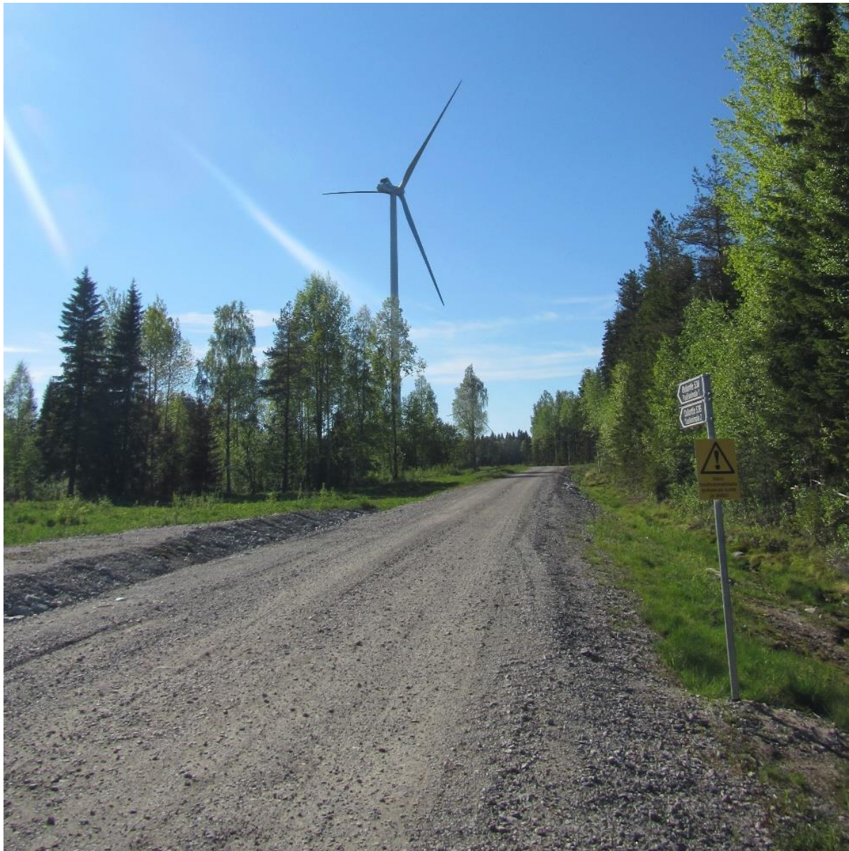
Kuva 3-2. Esimerkki tuulivoimapuiston rakennus- ja huoltotiestä. © AFRY Finland Oy.
