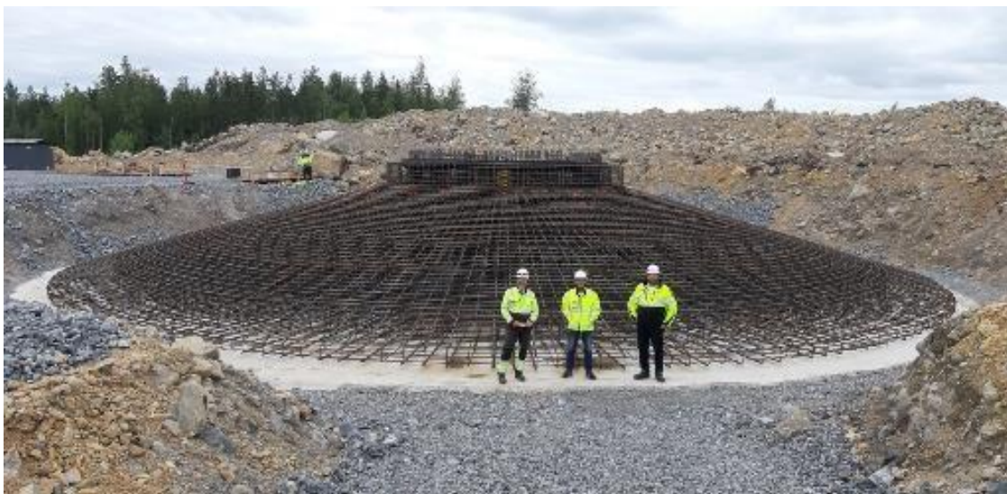
Kuva 3-4. Tuulivoimalan perustustyömaa. © Ilmatar Energy Oy.
