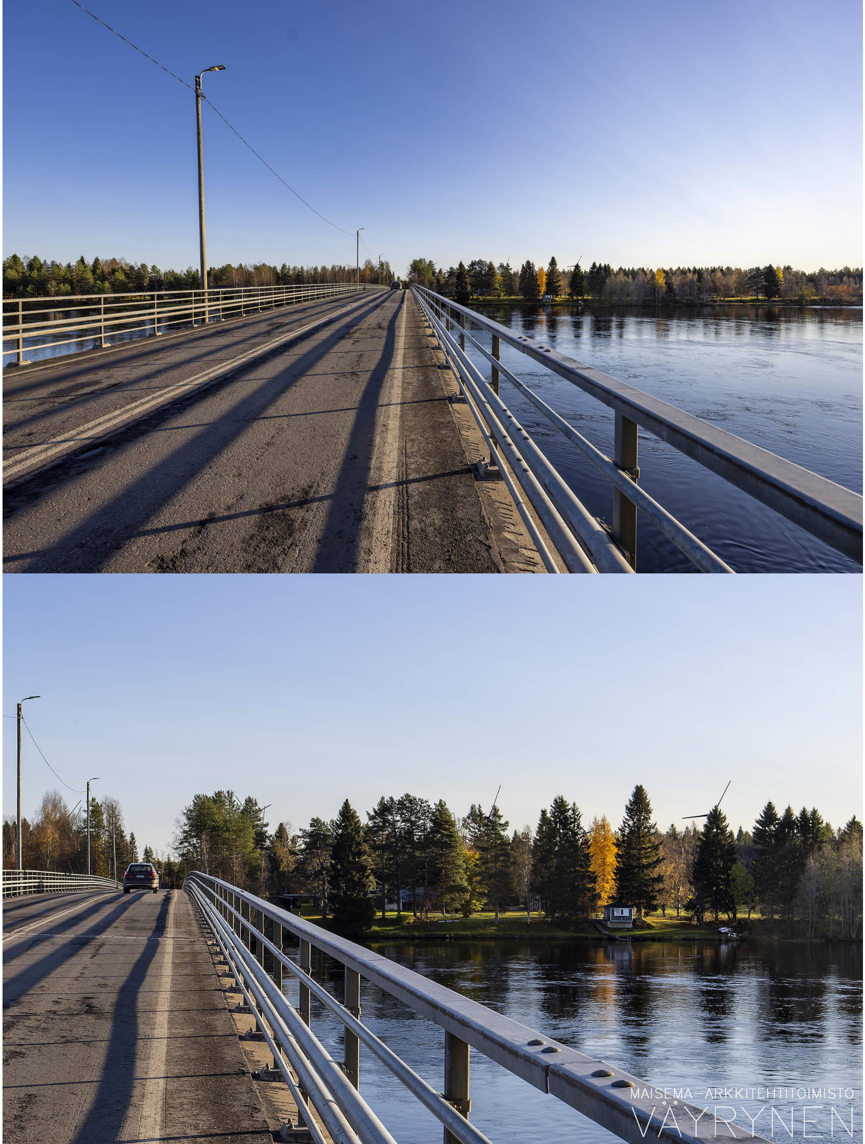
Kuva 6. Näkymä B Kiimingintien Iijoen ylittävältä sillalta kohti tuulivoimapuistoa. Yläkuvan objektiivi on 16 mm ja alakuva 50 mm. Etäisyys lähimpään tuulivoimalaan on 4,7 kilometriä.
