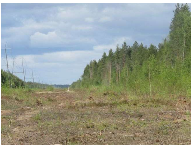
Kuva 43. Liittymäkohta Koivuhaka–Pyhäjärvi -ilmajohtoon.
