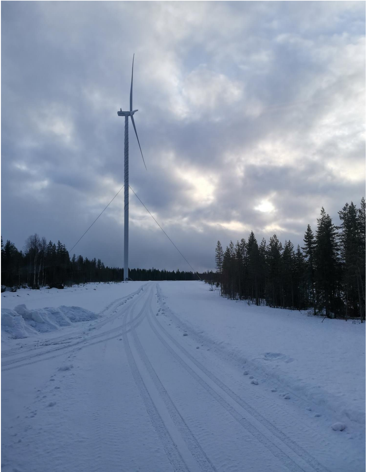
Kuva 31-1. Esimerkkikuva haruksellisista voimaloista (kuva: OX2).
