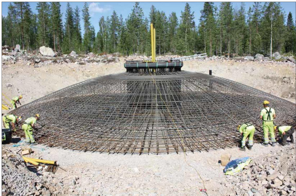
Kuva 5-4. Maanvarainen teräsbetoniperustus raudoitettuna ennen betonivalua.
