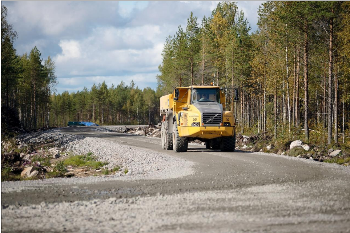
Kuva 6-7. Esimerkkikuva tuulivoimalan rakenteilla olevasta huoltotiestä (kuva: OX2).
