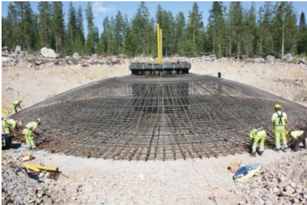
Kuva 6-3. Maanvarainen teräsbetoniperustus raudoitettuna ennen betonivalua.
