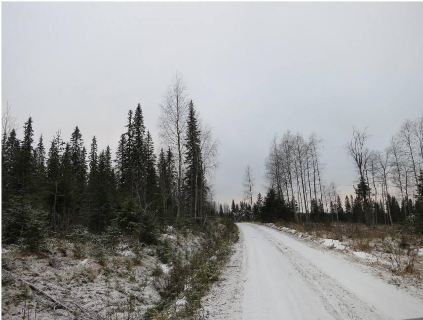
Kuva 3-7 Esimerkki tuulipuiston rakennus- ja huoltotiestä.
