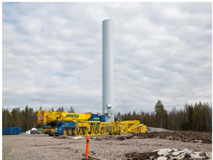
Kuvapari 5.13. Tuulivoimalan kokoamista. (Kuvat: Ville Suorsa, FCG)
