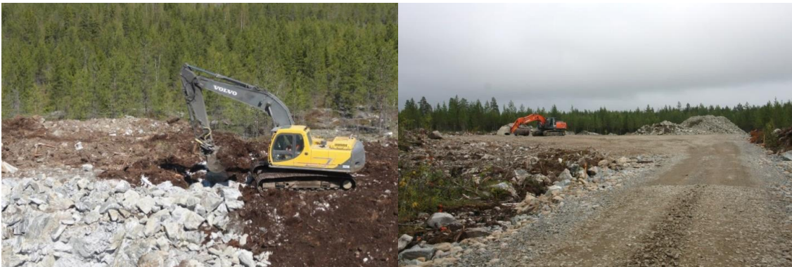
Kuvapari 5.10. Tuulivoimapuiston rakentaminen alkaa huoltoteiden ja pystytysalueiden rakentamisella (kuvat: Ville Suorsa, FCG).
