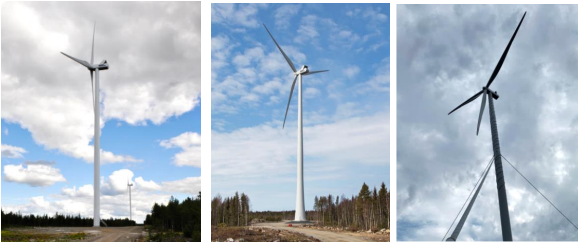
Kuva 5.2. Vasemmalla on esimerkki teräslieriötornista, keskellä hybriditornista ja oikealla harustetusta tornista. (Kuvat: Leila Väyrynen ja Ville Suorsa, FCG sekä Jarkko Finnilä, Carelin)
