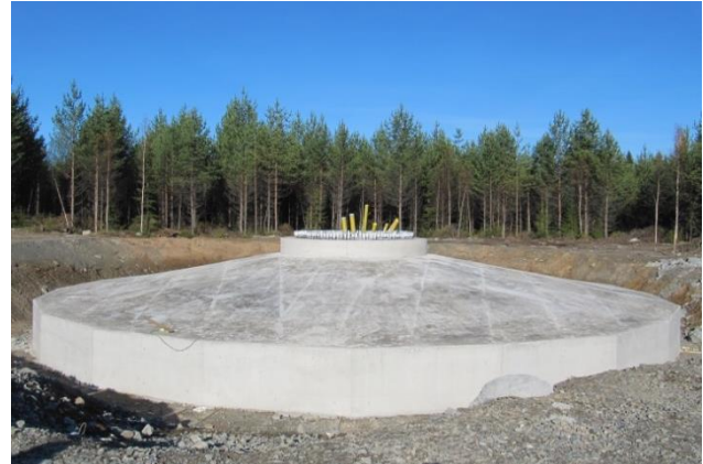
Kuvapari 5.12. Tuulivoimalan perustusten rakentamista. (Kuvat: Leila Väyrynen, FCG)
