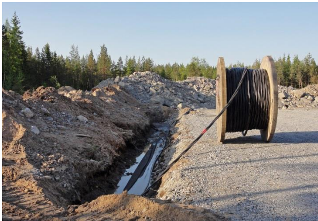
Kuvapari 5.11. Maakaapelit upotetaan huoltoteiden yhteyteen (kuvat: Ville Suorsa/FCG).
