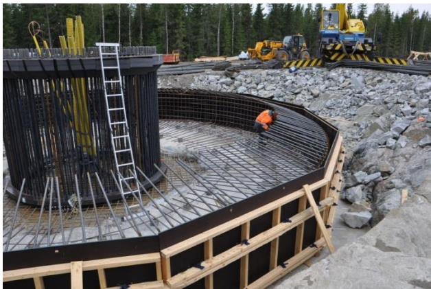
Kuvapari 5.12. Tuulivoimalan perustusten rakentamista. (Kuvat: Leila Väyrynen, FCG)
