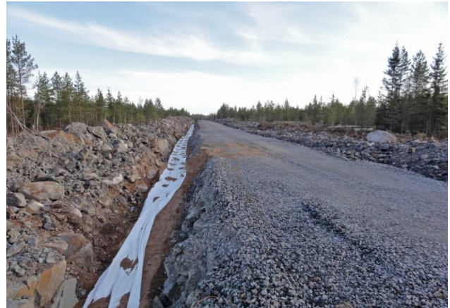
Kuvapari 5.11. Maakaapelit upotetaan huoltoteiden yhteyteen (kuvat: Ville Suorsa/FCG).
