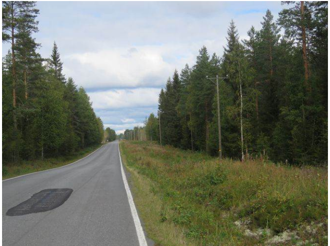
Kuva 28. Linjaus Pyhäntä-Kiuruvesi paikallistien kohdalla, pohjoiseen.
