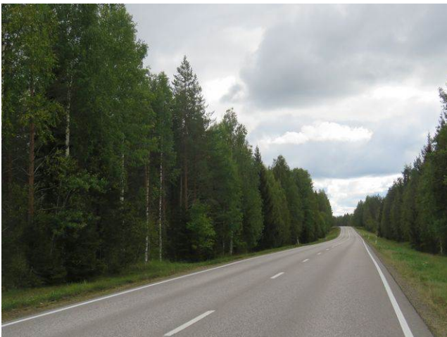
Kuva 41. Linjaus VT 88 koillispuolella, kaakkoon. .
