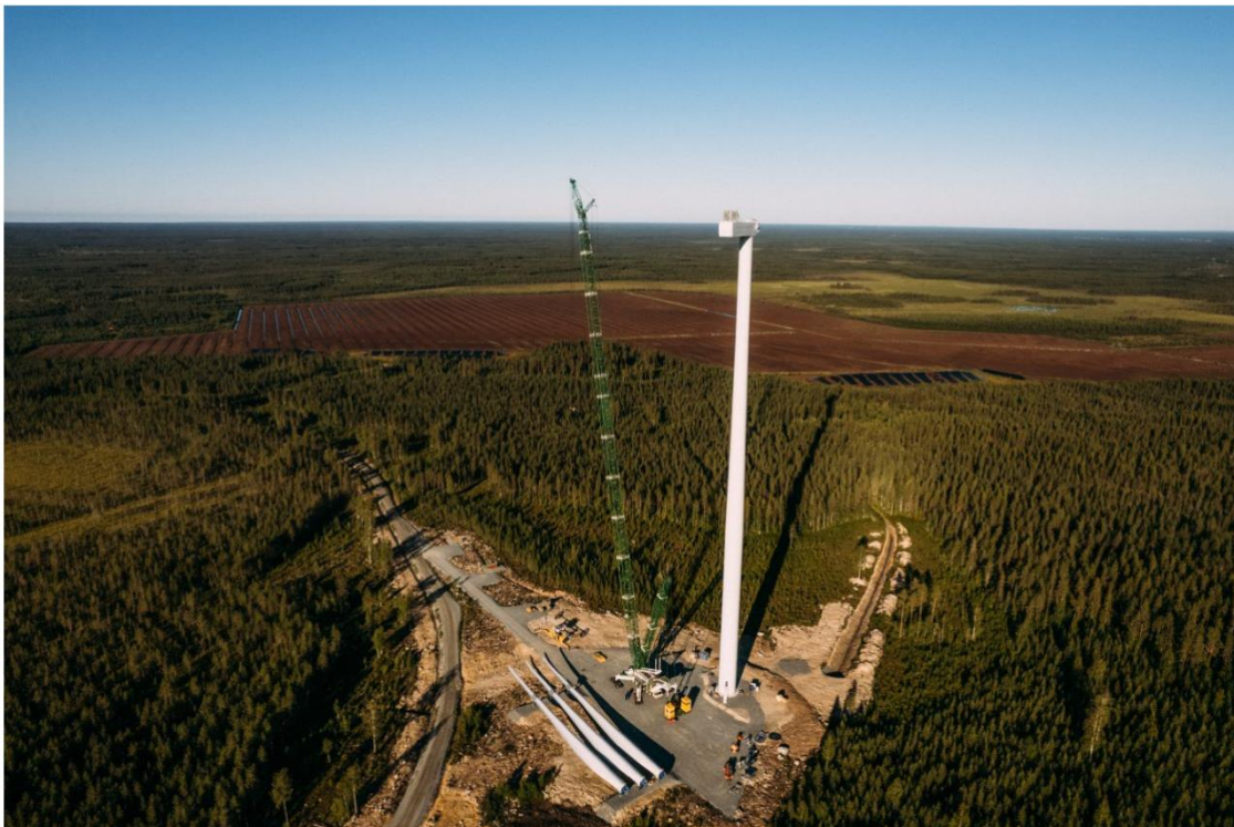
Kuva 3-4. Tuulivoimalan kokoaminen. © Ilmatar Energy Oy.
