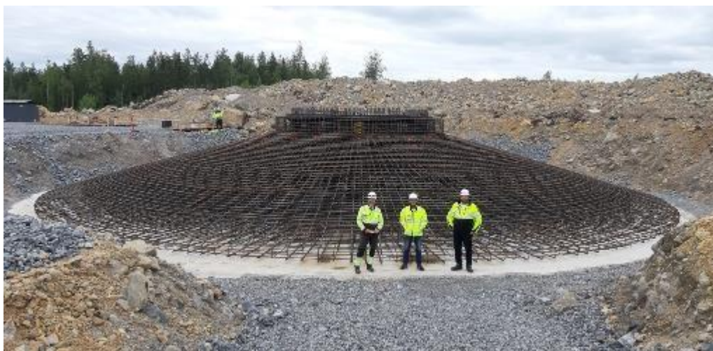
Kuva 3-5. Tuulivoimalan perustustyömaa. © Ilmatar Energy Oy.
