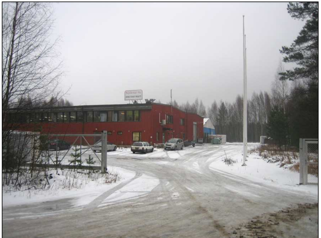
Kuva 11. Harjatehdas Villatien pohjoispäässä
