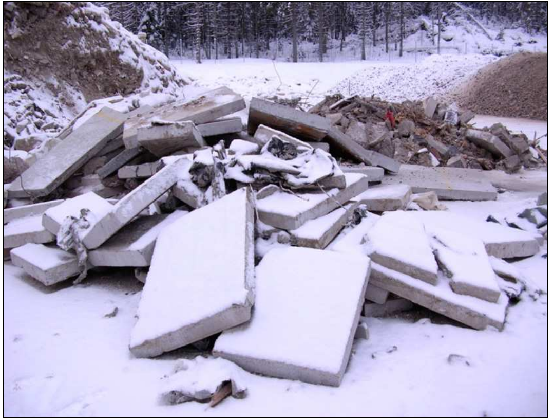
Kuva 2. Purkutoiminnassa syntyvää betonijätettä 6 .
