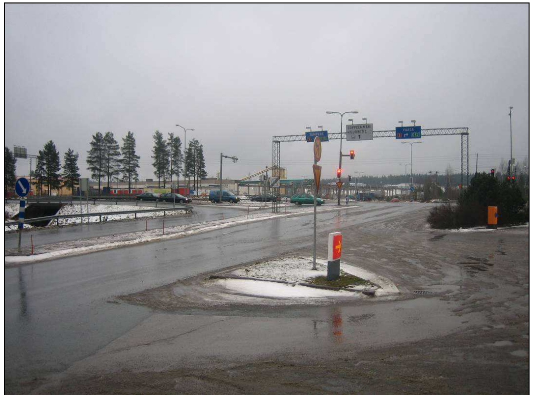
Kuva 17. Vaasantien (vt 3) ja Vanhan Vaasantien liittymä.
