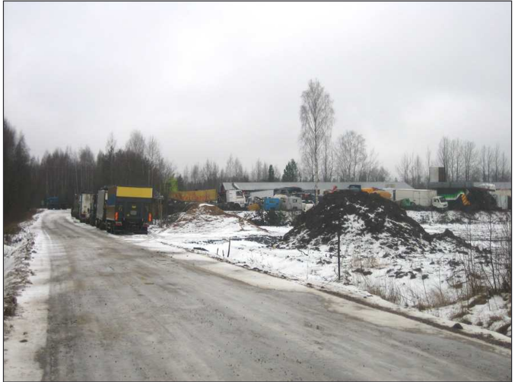
Kuva 10. Kuorma-autopurkamo hankealueen länsipuolella
