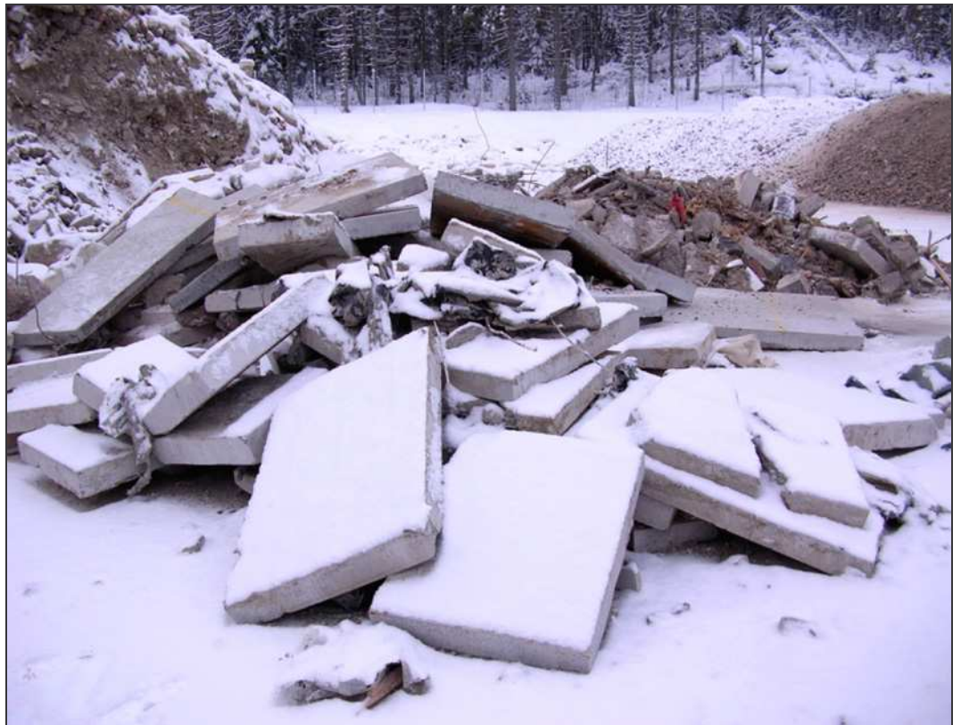
Kuva 2. Purkutoiminnassa syntyvää betonijätettä 5 .
