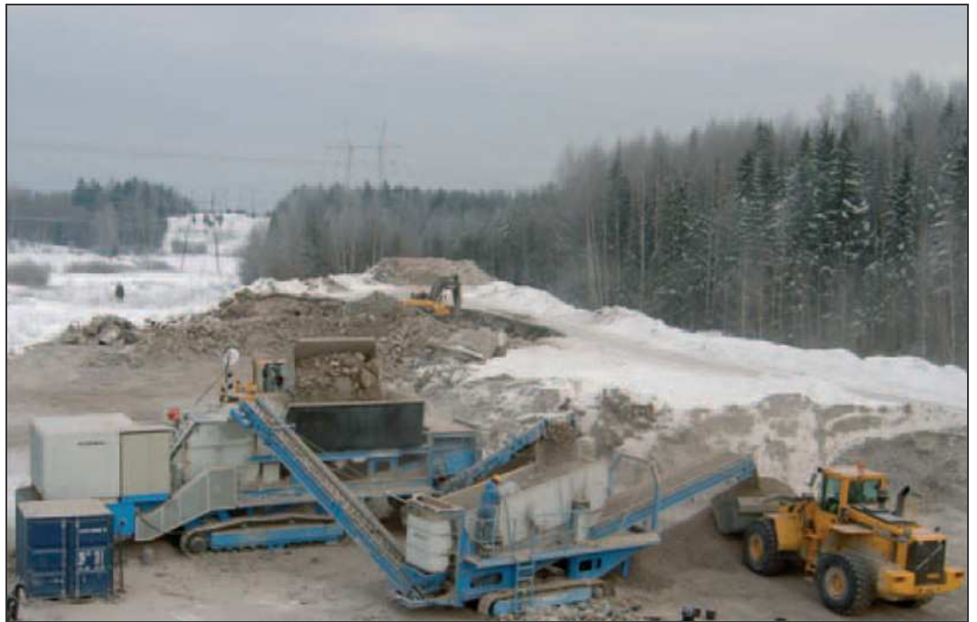
Kuva 8. Betonijätteen murskauslaitteisto toiminnassa 9 .
