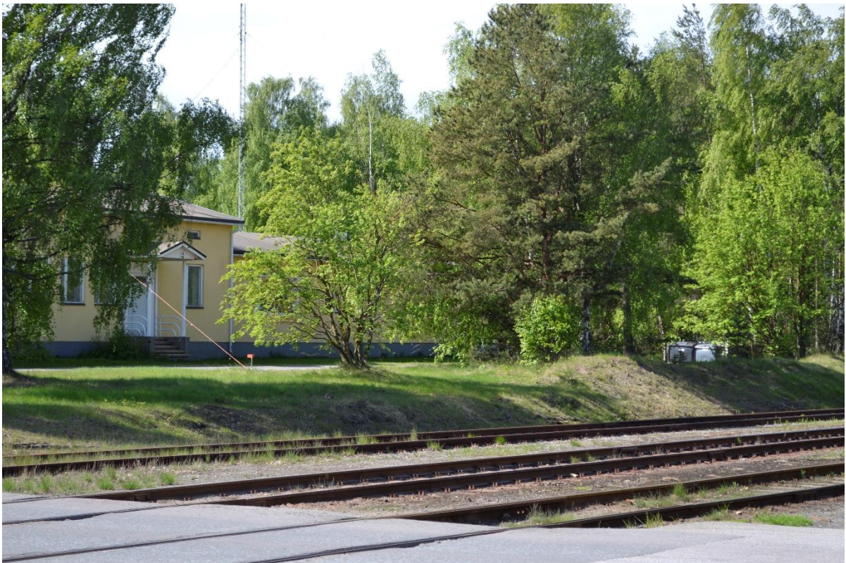
Kuva 12-11. Rautatietä Metsäkadulta kuvattuna. Radan varrella ei ole tällä hetkellä melusuojarakenteita.
