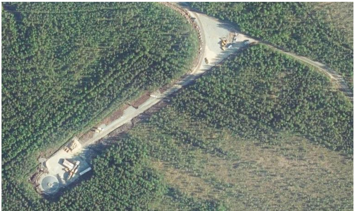
Kuva 6–5. Esimerkkikuva tuulivoimalle johtavasta huoltotiestä ja nostoalueesta. (Ilmakuva: MML, avoimet aineistot 2022)
