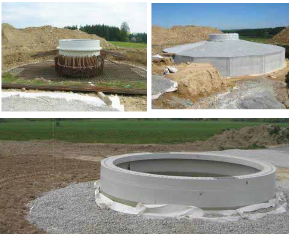
Kuva 3-11. Perustuksen rakentamisvaiheita. (Kuva © Ventureal)
