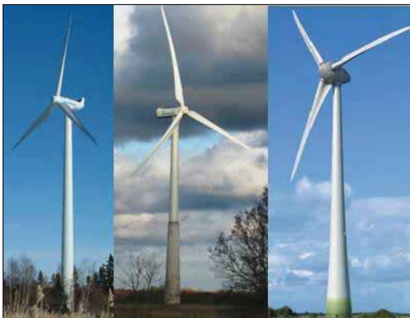
Kuva 3-9. Tuulivoimalan tornityyppejä, vasemmalla terästorni, keskellä betoni- ja terästornin yhdistelmä ja oikealla täysbetonitorni. (Kuvat: WinWinD ja Enercon).
