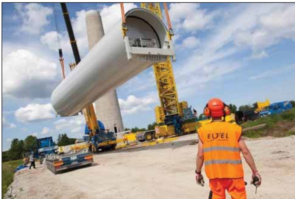
Kuva 3-15. Tornilohkon nostaminen (Kuva: Eltel Networks Oy).
