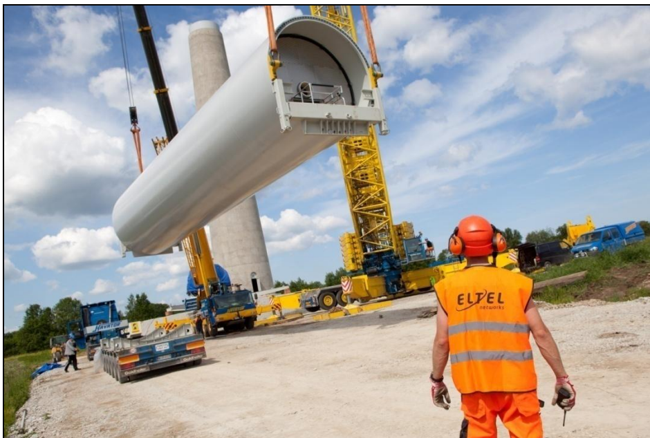
Kuva 3-14. Tornilohkon nostaminen (Kuva: Eltel Networks Oy).
