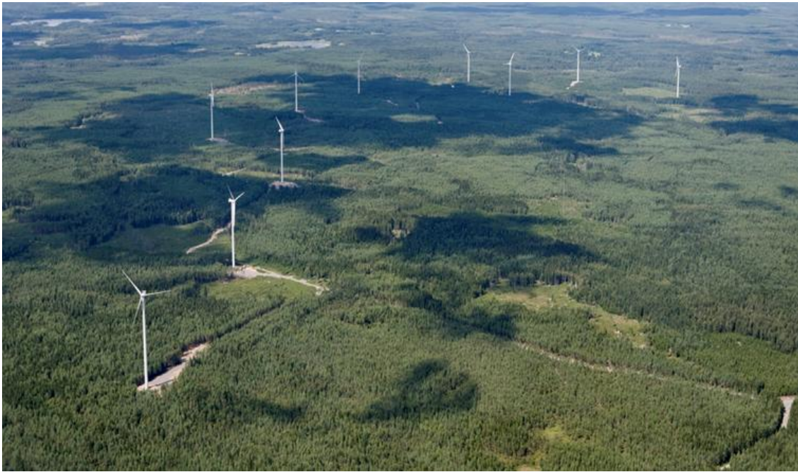
Kuva 3-6. Tuulipuisto metsäisellä alueella. Stengårdsholman tuulipuisto Ruotsissa, 10 voimalaa à 2 MW, napakorkeus 125 m, roottorin halkaisija 90 m. Kuva: © EON.
