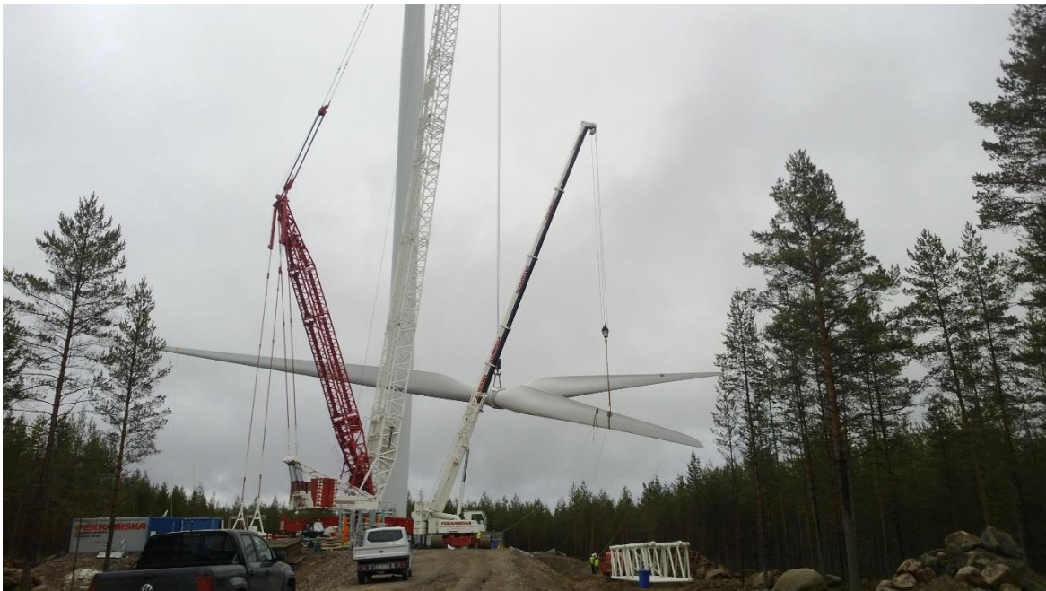
Kuva 17. Esimerkkikuva voimalan lapojen nostamisesta nosturilla (kuva: Taaleri Energia).
