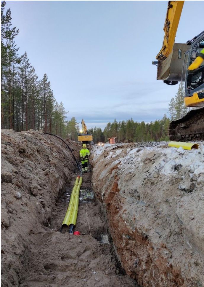
Kuva 15. Esimerkkikuva tuulivoimalan kaapeliasennuksista (kuva: Taaleri Energia).
