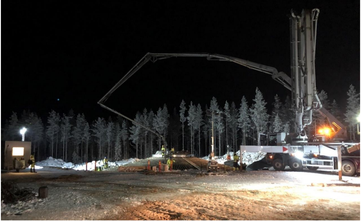
Kuva 14. Esimerkkikuva tuulivoimalan perustusten valusta (kuva: Taaleri Energia).
