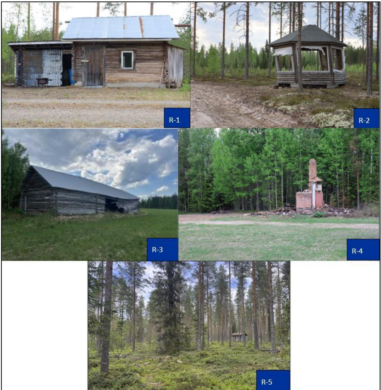
Kuva 151. Hankealueella sijaitsevat rakennukset.
