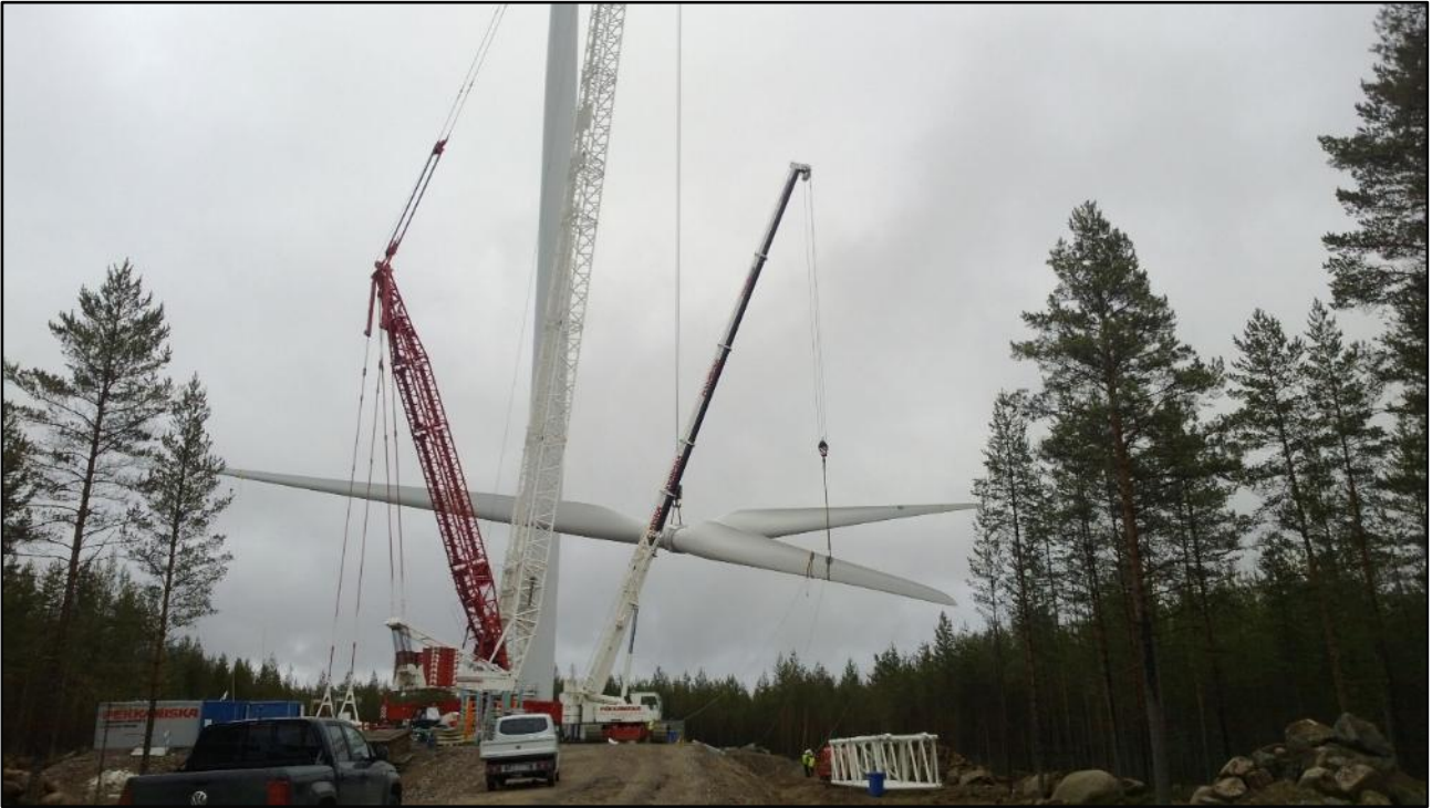
Kuva 38. Esimerkkikuva voimalan lapojen nostamisesta nosturilla (Taaleri Energia Oy).
