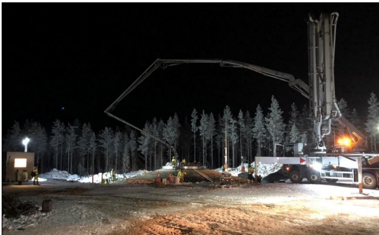
Kuva 14. Esimerkkikuva tuulivoimalan perustusten valusta (Taaleri Energia Oy).
