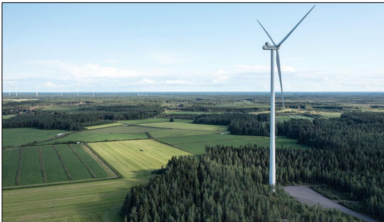
Kuva 17. Valmis voimalaympäristö (Taaleri Energia Oy)
