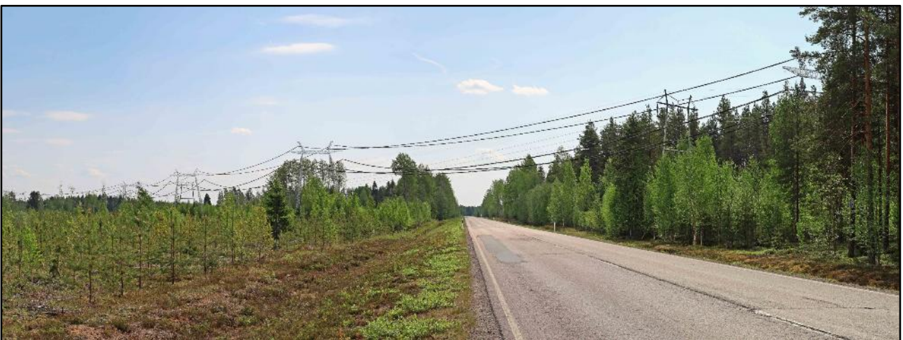
Kuva 96. Havainnekuva Hautakankaalta (3), jossa voimajohto SVE1 ylittää Raahentien. Etäisyys voimajohtoon 100 metriä. (Etha Oy)
