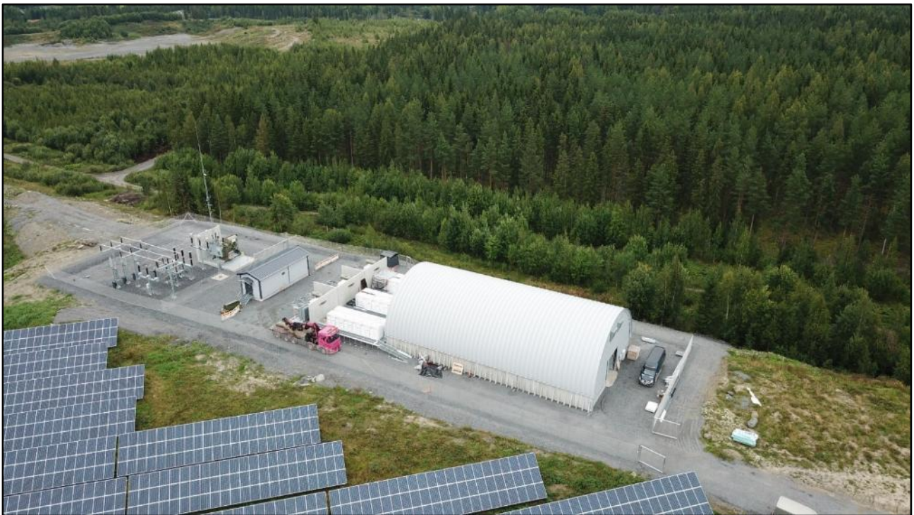
Kuva 29. Havainnollistava kuva katetusta sähköasemasta ja akkuvarastosta. Kuvan akkuvaraston teho ja kapasiteetti ovat pienemmät (30MW/36MWh) kuin Kivinevalle on suunniteltu. Akkuvaraston kattamisen tarve selviää tarkemman suunnittelun yhteydessä (Taaleri Energia Oy).
