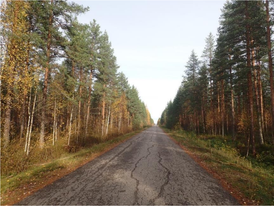
Kuva 2. Lehtolantie sähkönsiirtoreitin kohdalta. Isojakokarttaan merkitty tielinjaus Oulusta Kuopioon on kulkenut samalla kohtaa kuin nykyinen tielinjaus. Koilliseen.
