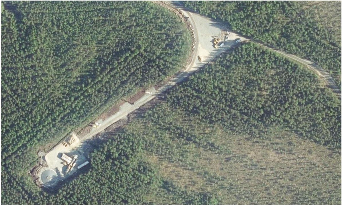
Kuva 6 Esimerkki tuulivoimalan rakennustyömaasta. Ilmakuvan lähde: Maanmittauslaitos, avoimet aineistot 2022.
