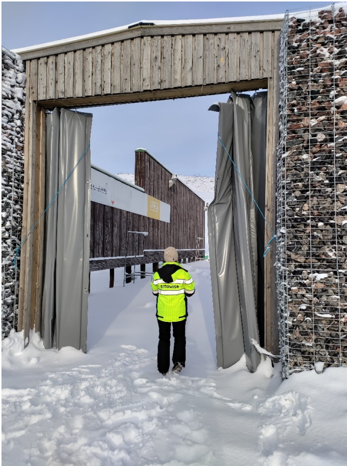
Kuva 10-5 Ampumaradan etelälaidan kivekorimuuri ja oviaukot. Kuvassa olevan henkilön pituus on noin 170 cm.
