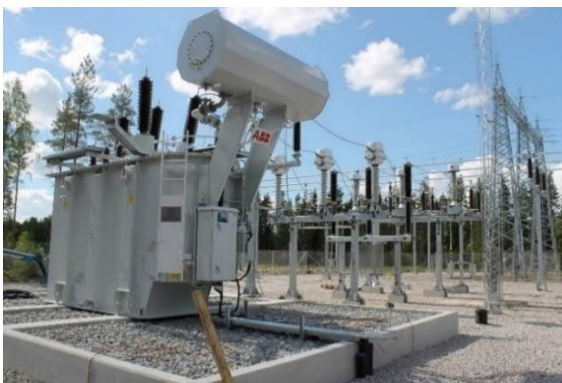
Kuva 3-2. Maakaapelin laskemistyöt (vasemmalla) ja esimerkki tuulivoimahankkeen 20/110 kV sähköasemasta (oikealla) © ABO Wind
