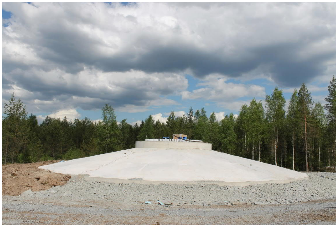
Kuva 3-8 Tuulivoimalan valmis perustus. © ABO Wind
