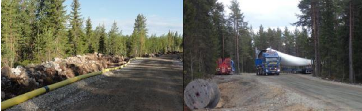
Kuva 5-6 Vasemmalla esimerkki tuulivoimapuiston rakennus- ja huoltotiestä. Oikealla tuulivoimalan osia kuljetetaan erikoiskuljetuksina (FCG Rakennettu Ympäristö Oy).
