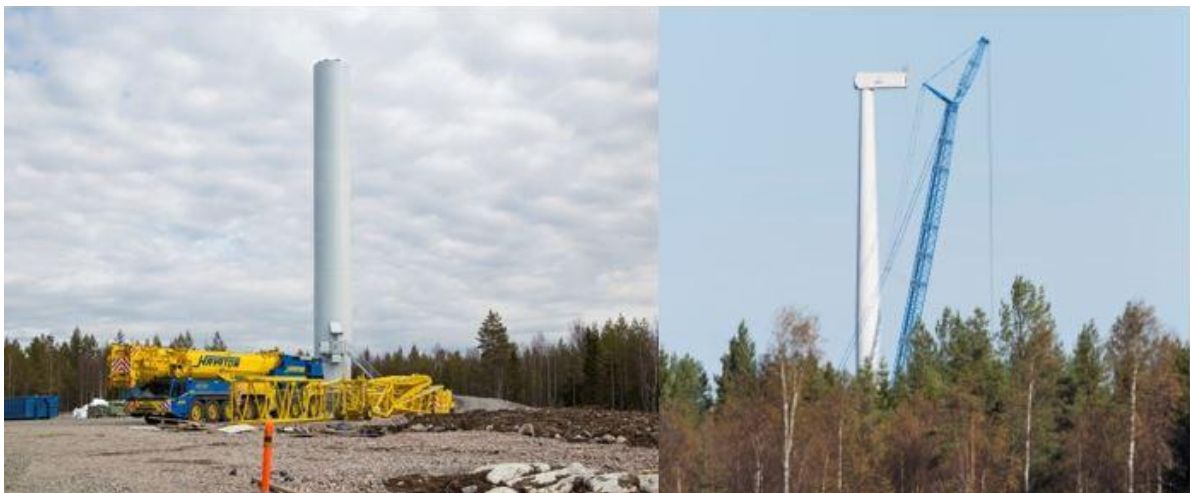
Kuva 5-13 Tuulivoimalan kokoamista (FCG Rakennettu Ympäristö Oy).
