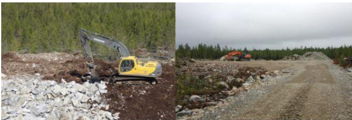
Kuva 5-10 Tuulivoima-alueen rakentaminen alkaa huoltoteiden ja pystytysalueiden rakentamisella (FCG Rakennettu Ympäristö Oy).
