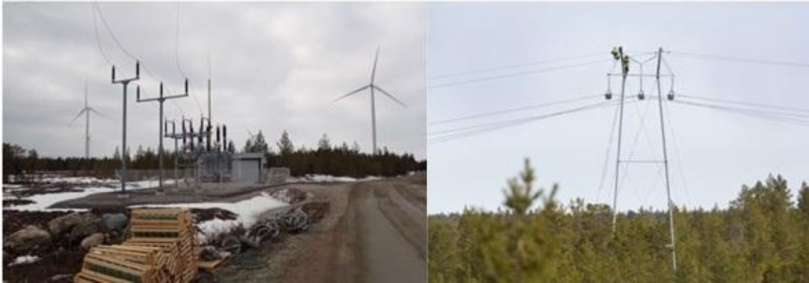
Kuva 5-15 Sähköaseman ja voimajohdon rakentamista (FCG Rakennettu Ympäristö Oy).
