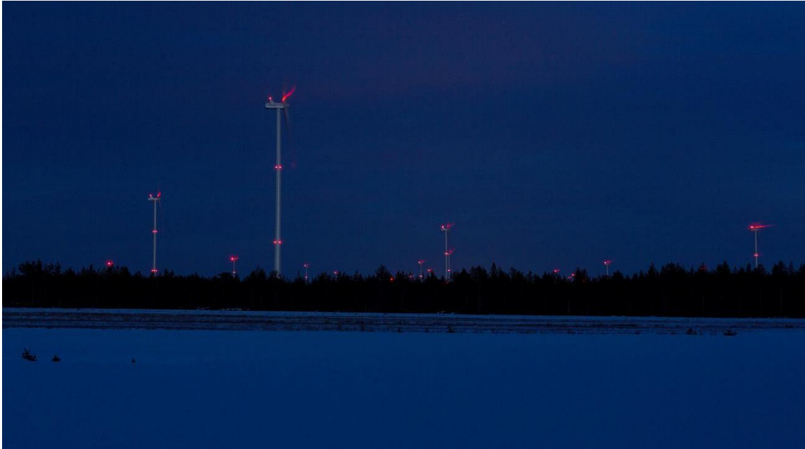
Kuva 5-4 Kiinteät punaiset lentoestevalot (FCG Rakennettu Ympäristö Oy).
