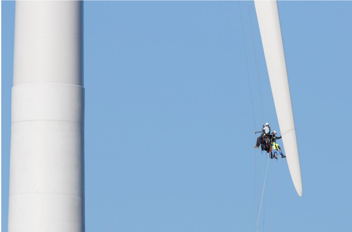
Kuva 5-16 Tuulivoimalan huoltotoimenpiteitä (FCG Rakennettu Ympäristö Oy).
