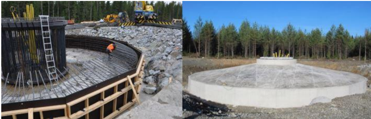
Kuva 5-12 Tuulivoimalan perustusten rakentamista (FCG Rakennettu Ympäristö Oy).
