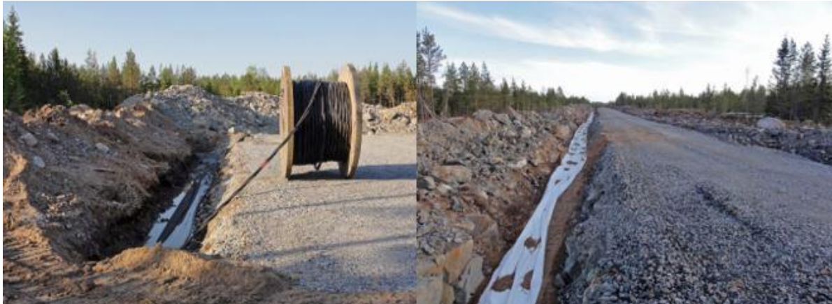
Kuva 5-11 Maakaapelit upotetaan huoltoteiden yhteyteen (FCG Rakennettu Ympäristö Oy).
