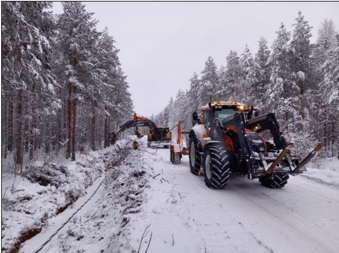
Kuva 7. Esimerkkikuva kaapelin asentamisesta kaapeliojaan (Lähde: ABO Wind Oy).
