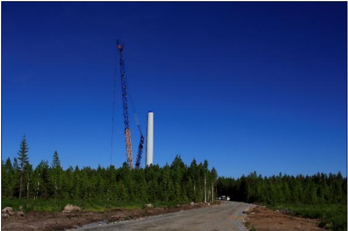
Kuva 12. Esimerkkikuva tuulivoimalan tornin pystyttämisestä nosturilla (Lähde: ABO Wind Oy).
