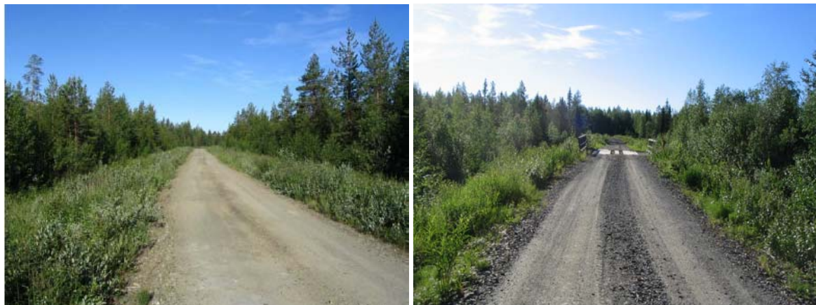
Kuva 11.5. Vajukoskelta Kevitsaan menevä tie ja Mataraojan silta..
