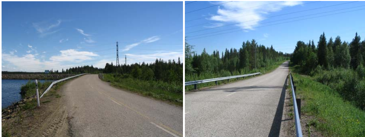
Kuva 11.4. Petkulan kylätie (pt 19809) Vajukosken voimalaitoksen risteyksen kohdalla pohjoisesta nähtynä.
