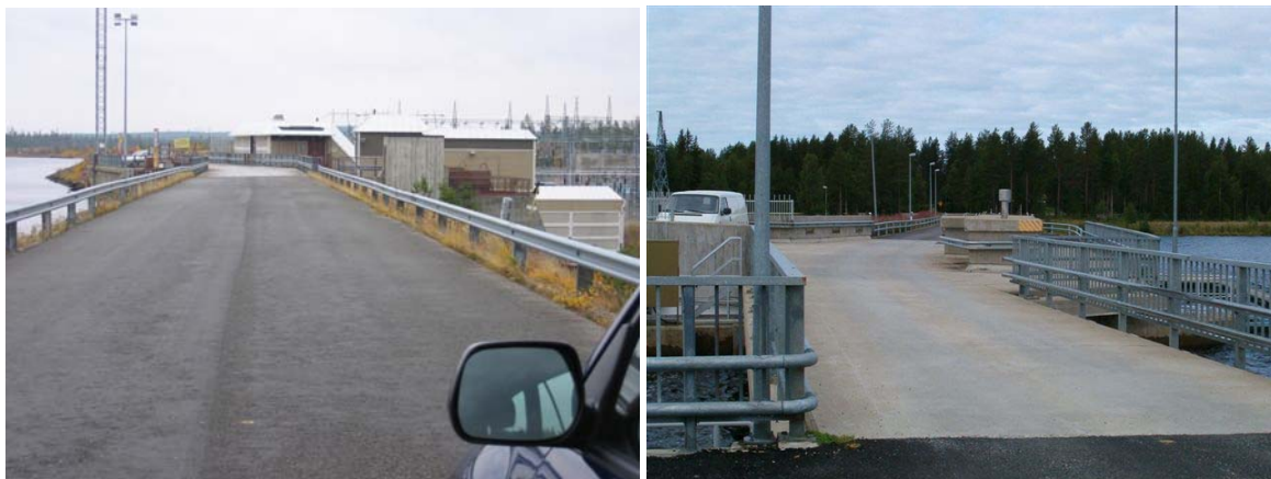
Kuva 7.10. Vajukosken voimalaitossilta lännestä ja Matarakosken voimalaitossilta idästä.
