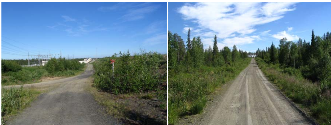
Kuva 7.11. Kevitsan tie Vajukosken voimalaitoksen itäpuolella ja Kitisen itäpuolen tie Vajukosken ja Matarakosken välillä.
