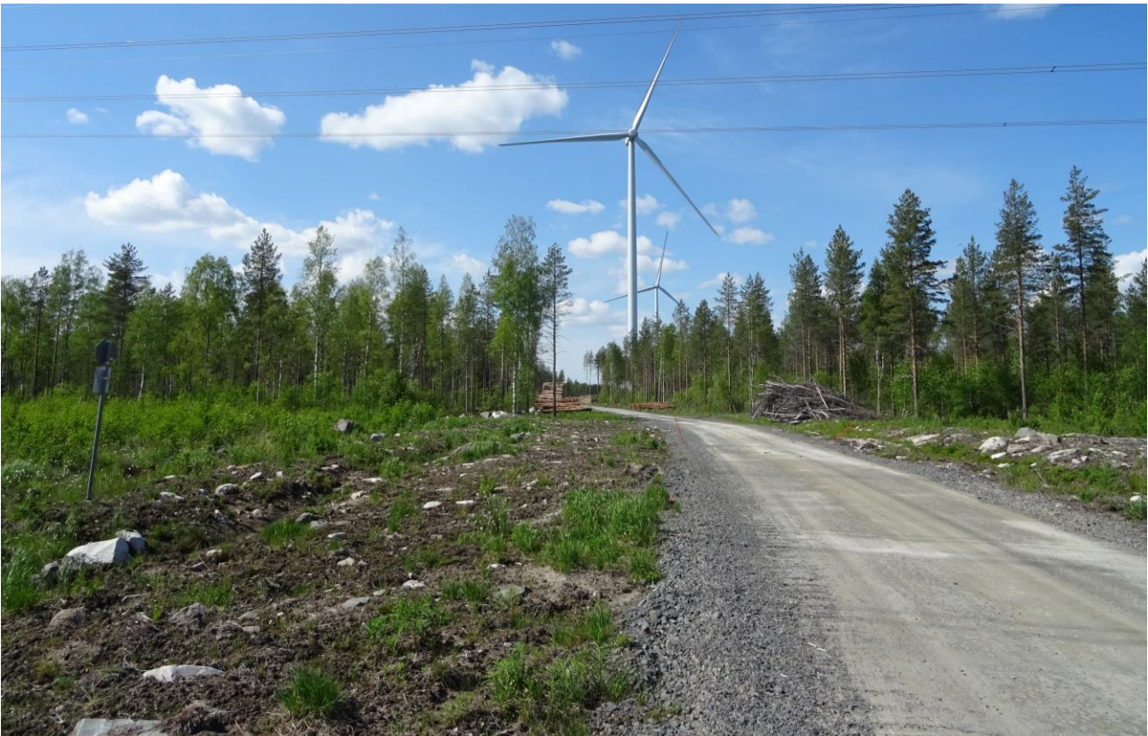
Kuva 16. Esimerkki tuulivoimapuiston rakennus- ja huoltotiestä. Maakaapelin oja on sijoitettu tien vasemmalle puolelle. Teitä käytetään muun muassa betonin ja soran sekä voimaloiden komponenttien kuljetuksiin. Tuulivoimapuiston käyttövaiheessa teitä käytetään mm. vuosittaisissa huolloissa. (Kuva: Sweco Finland Oy.)
