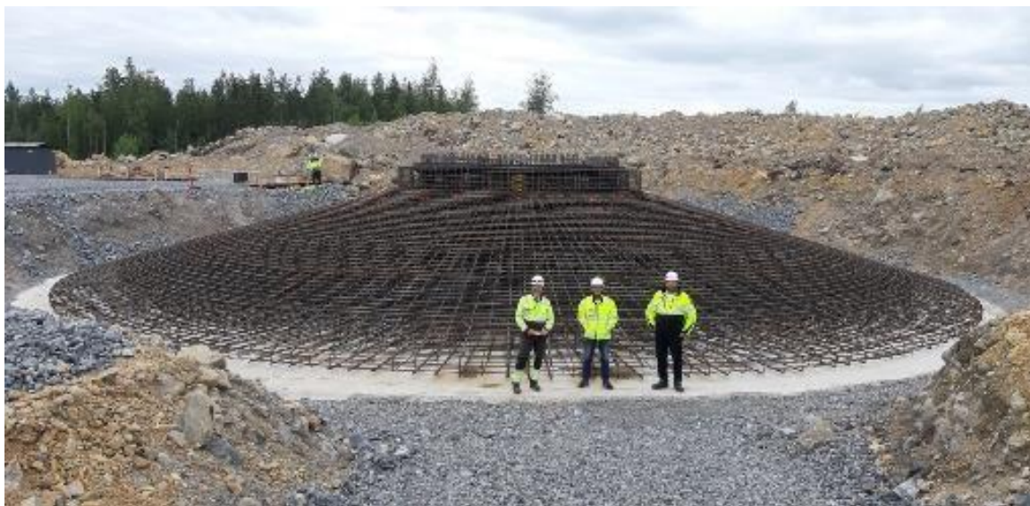
Kuva 3-8. Tuulivoimalan perustustyömaa. © Ilmatar Energy Oy.
