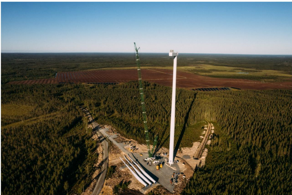
Kuva 3-7. Tuulivoimalan kokoaminen. © Ilmatar Energy Oy.
